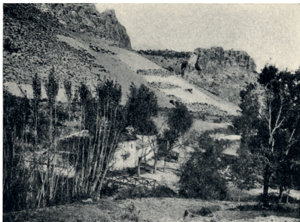
Fig. 19. Posada del Molinillo, desde la ladera de la montaña (Foto: id., op. cit. , pág. 165).
